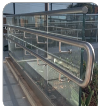
Guarda-Corpo com Vidro
